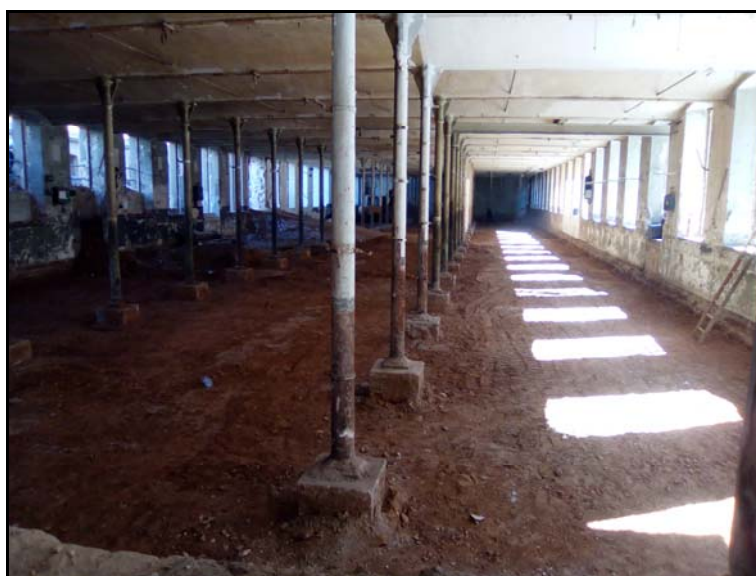
Fotografia 2. Vista interior de la nau central de l'edifici B, un cop realitzats els rebaixos.
