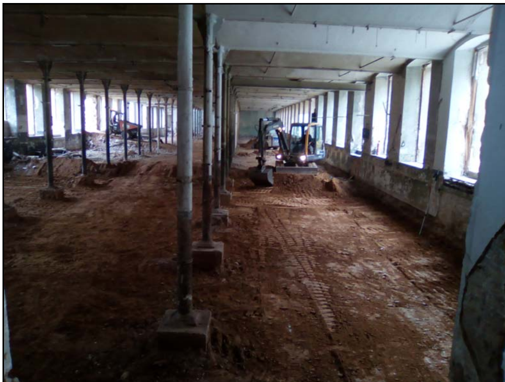
Fotografia 3. Un altra vista de la nau central de l'edifici B mentre es duien a terme els rebaixos.
