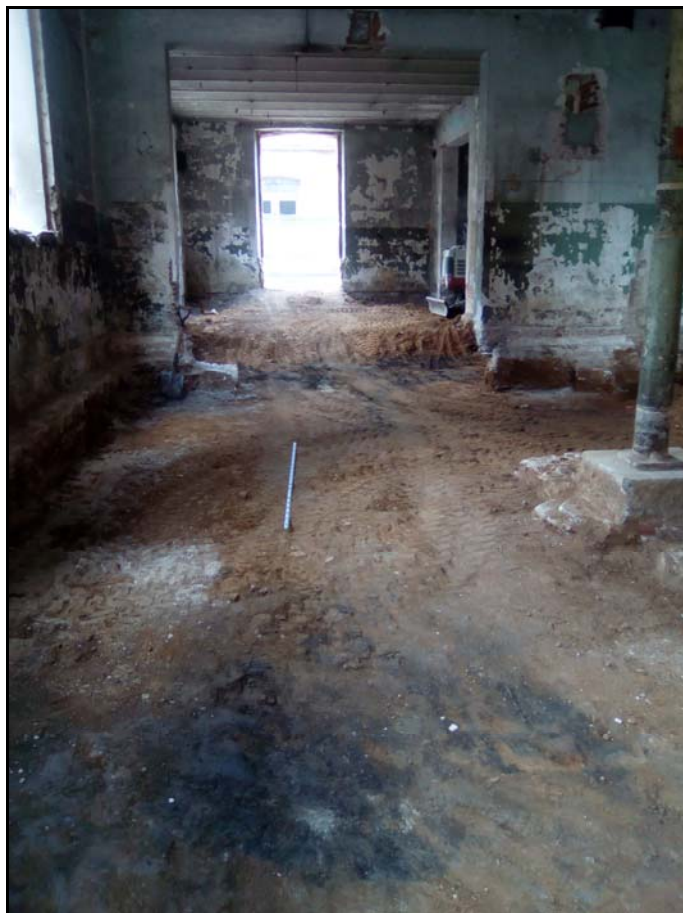
Fotografia 15. Detall de l'espai B un cop finalitzat el rebaix.
