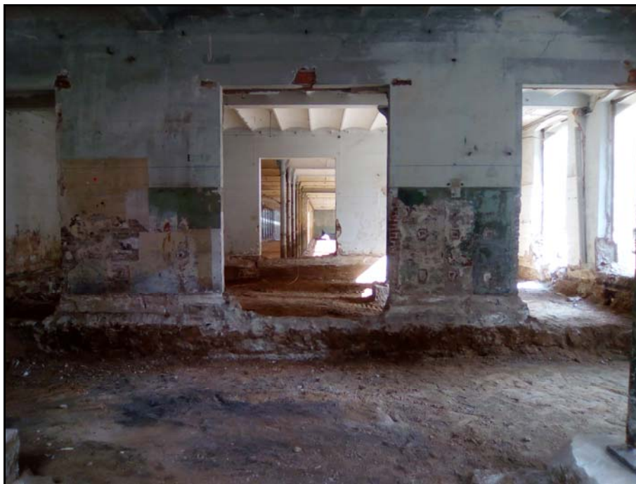
Fotografia 5. Vista dels àmbits intervinguts amb la nau central B al fons.
