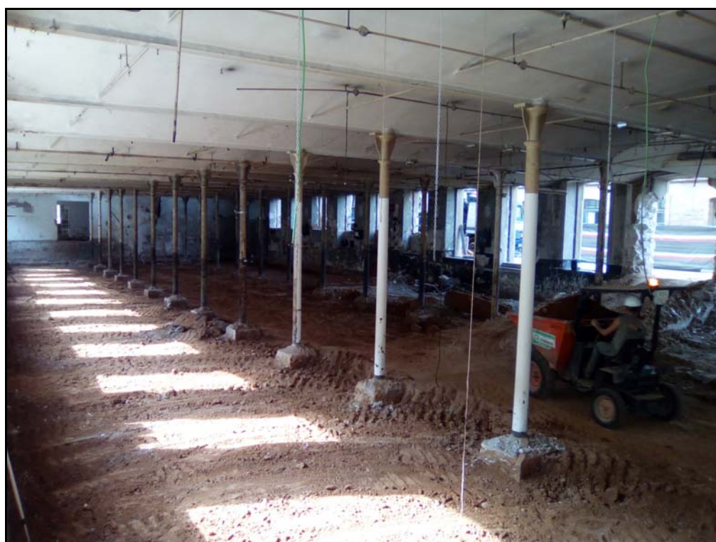
Fotografia 4. Un altre moment dels treballs a l'edifici B.
