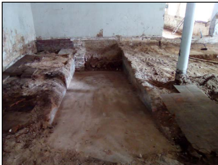
Fotografia 11. Detall de la rampa localitzada durant els treballs.
