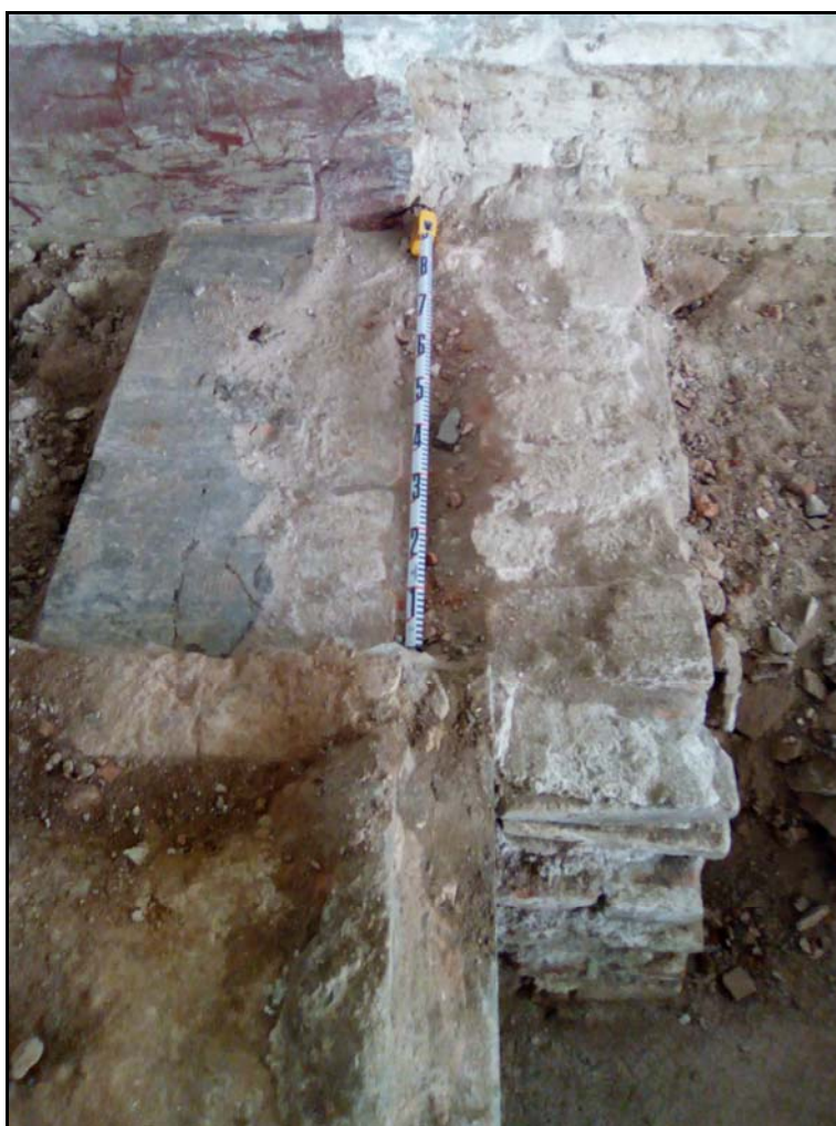
Fotografia 12. Detall d'un esglaó de formigó (UE16) i d'un mur (UE23) posterior a la rampa de la fotografia 11.
