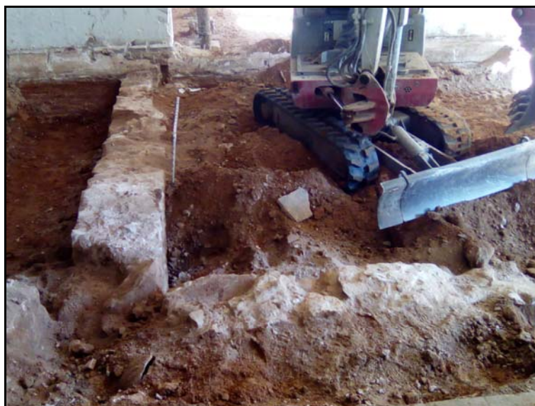
Fotografia 10. Detall de les riostes UUEE 21 i 22 localitzades durant els rebaixos.
